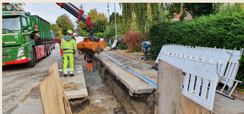
FIGUR 1: Durapor fyldes i grav før nedlægning af rør.
