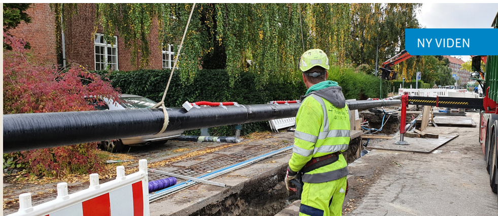
FIGUR 2: 24 meter fjernvarmerør med påmonteret måleudstyr bliver nedsænket i grav.
