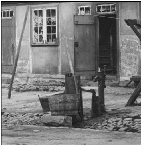
En vandpost på gårdspladsen.
